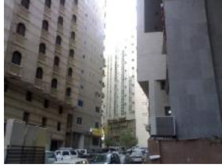
صورة رقم (1-3): خطر تعرض المباني المجاورة للحريق، (مباني مدينة مكة المكرمة، الباحث).
